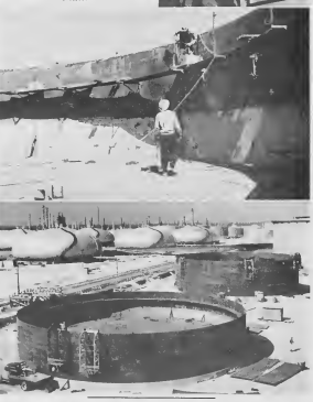
DEN VARIOS fase di construcion den tank farm tin tres tanki grandi di gasoline. Entun di nan grandi tin un capacidad di 80,000 barril. Tur ta tanki cu dak flotante. Pa motivo di especificacion special incorporá den nan disenjo, e tankinan por usa plachi di asteel mas fin y seyo di dak mas eficiente.
